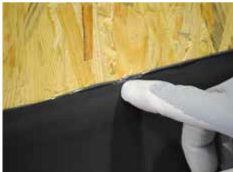
An Stellen, an denen keine Dichtungspaste hervorquillt, leicht mit dem Finger drücken oder zusätzlich Dichtungspaste einspritzen.
