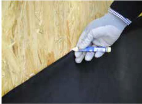
Kartusche öffnen und wie oben beschrieben in die Auspresspistole einsetzen. Auf dem Untergrund die Linie markieren, auf der später die Folienkante verlaufen wird.
