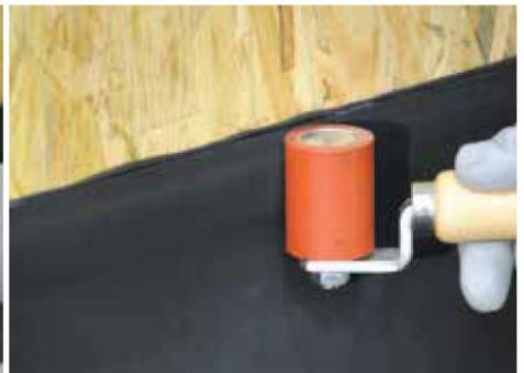
Nach 10 Minuten erneut Nahtroller mit mittlerem Druck über die obere Folie führen. Die Verbindungsstelle frühestens nach 48 Stunden mit mäßigem Zug. Durch Dichtungspaste verursachte Flecken entfernen.
