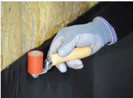
Die Folie auf den Untergrund drücken und mit dem Nahtroller weich über die Folie fahren, bis die Dichtungspaste aus dem Folienrand hervorquillt.
