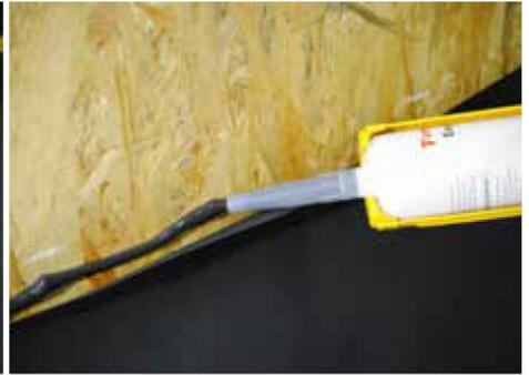
1 cm unter der Folienkante zwischen Wand und Folie mit einer Geschwindigkeit von ca. 6 s pro 10 cm einen durchgehenden Strang Dichtungspaste (mind. 5 mm breit) auftragen. Die Dichtungskartusche nach jedem Gebrauch verschließen.
