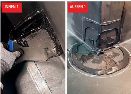
Mit einer biegefähigen Blattspachtel aus Stahl die äußeren MagicPower-Stränge vorsichtig flachdrücken. Überschüssiges MagicPower kann auf Flächen ohne MagicPower abgestreift werden.
